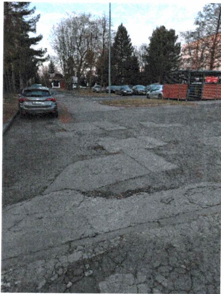
Stan nawierzchni jezdni ul. Rodakowskiego 47 – 55 (działki: 3401/5, 3405/5).
