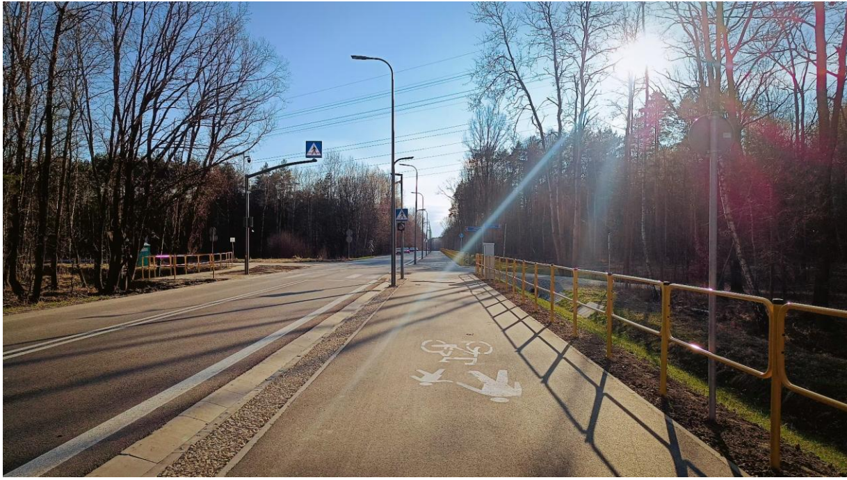
2. Rozbudowa ul. Lokalnej.
