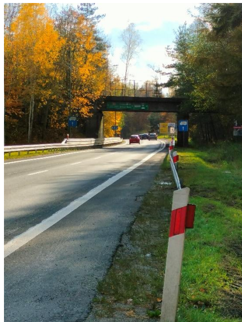
Przykład zastosowanych słupków hektometrowych 2025r.
