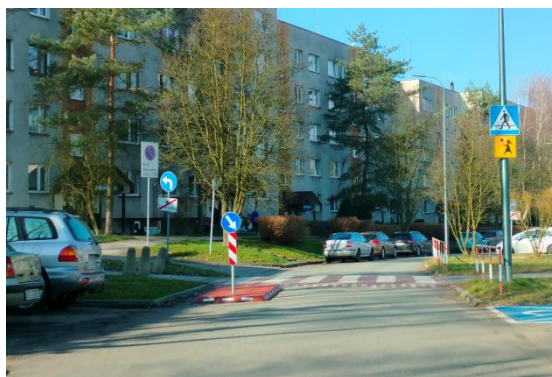
Wyniesienie przejścia wraz z szykaną
